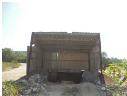
รูปที่ 2-12: การปิดคลุมถังรับหินใหญ่
